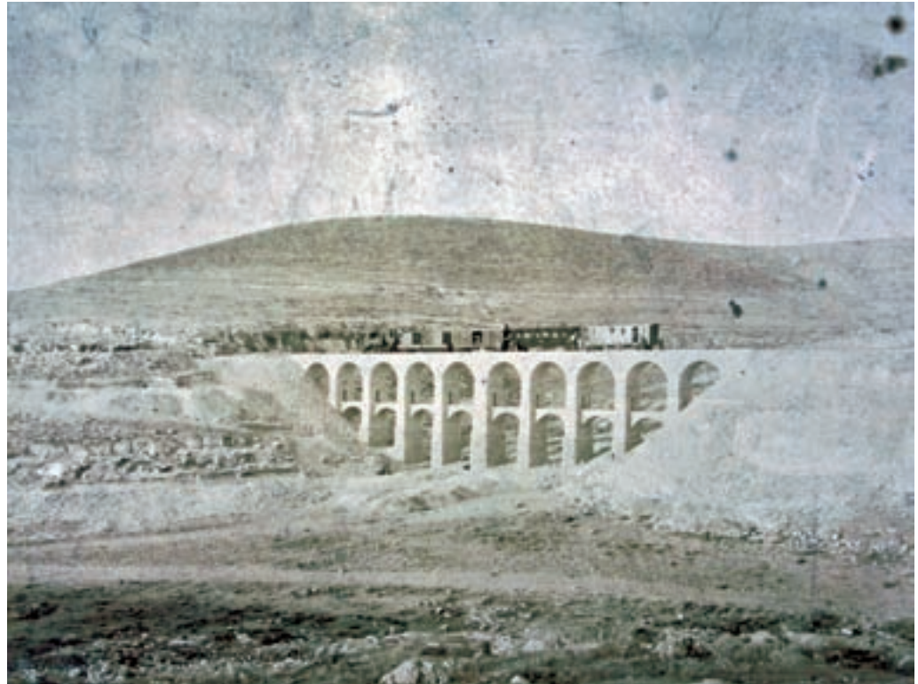
I Hamidiye Hicaz Demiryolu'nun iki yüz otuz ikinci kilometresindeki büyük köprünün batı tarafından görünümü,
